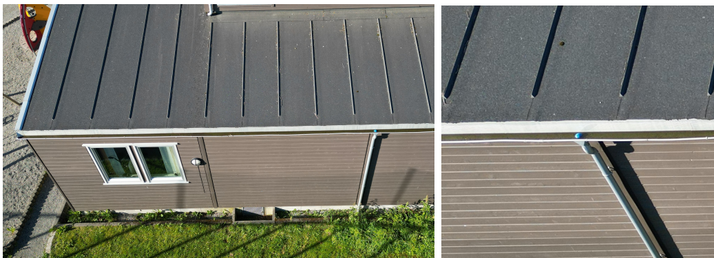
Figur 4.6: Dronebilde fra fortetning av nedløpsrør. Foto: Trondheim kommune.
