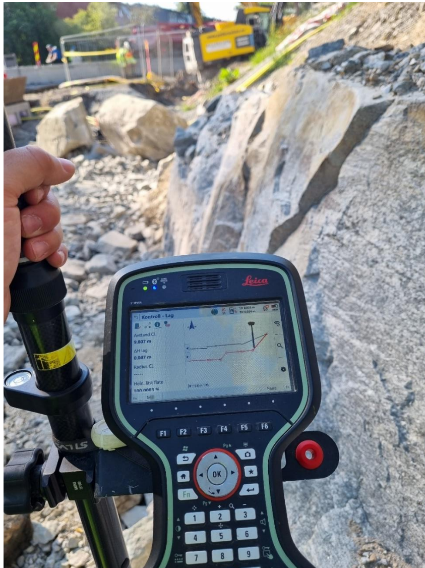
Figur 1: Kontroll av sprengning for veg. Måleboken viser det aktuelle tverrprofilen i vegmodellen, med avstand fra målt punkt til teoretisk sprengningsprofil.
