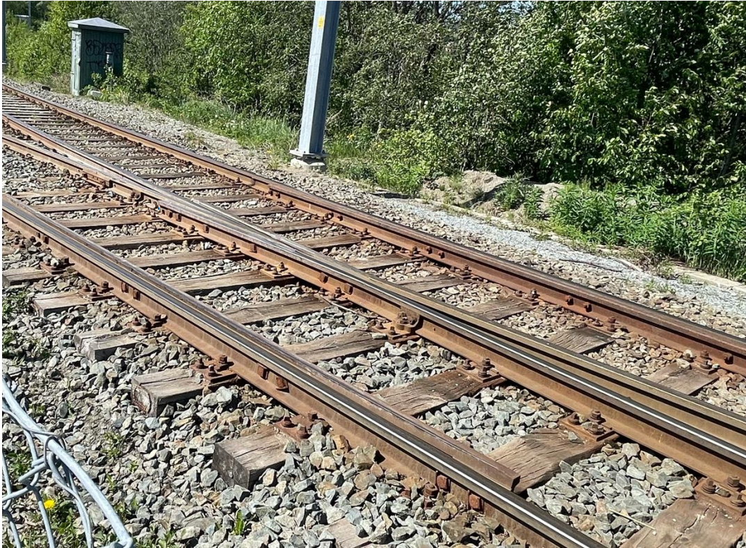
Figur 2-6: Tresviller brukt i overgangen fra bro til vanlig spor. Bilde tatt ved Stavne bru.
