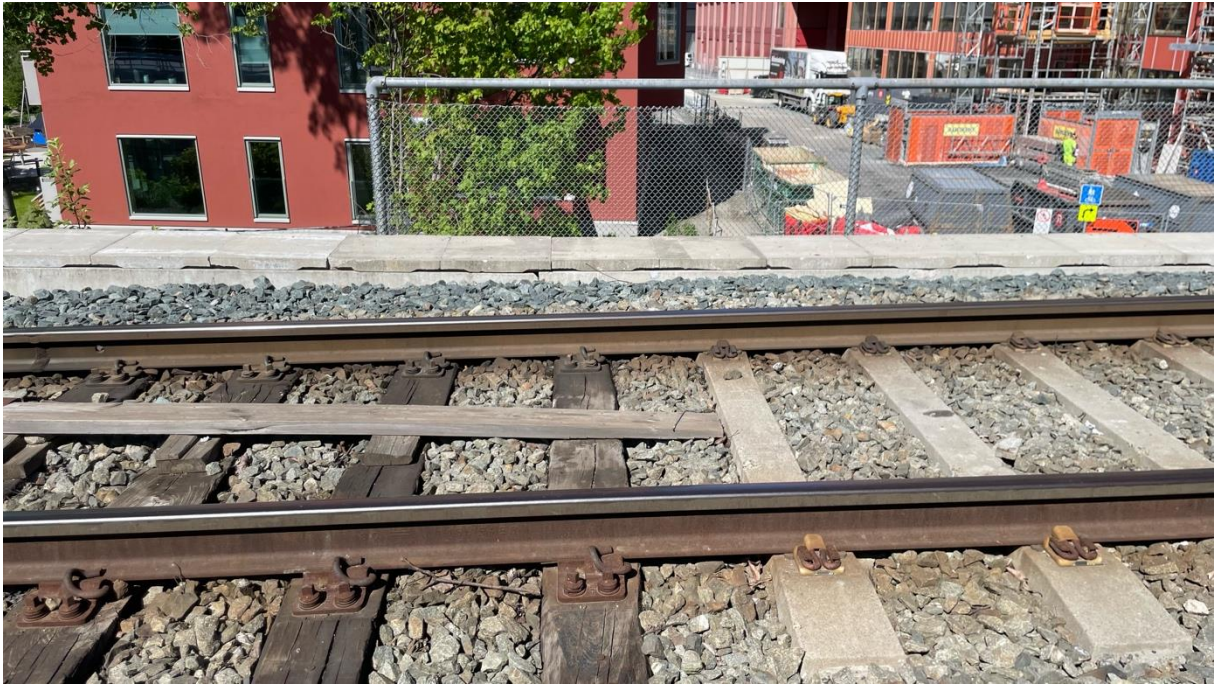
Figur 2-9: Overgang fra tresviller til betongsviller i Norge. Bilde tatt ved overgang fra bro til vanlig spor.
