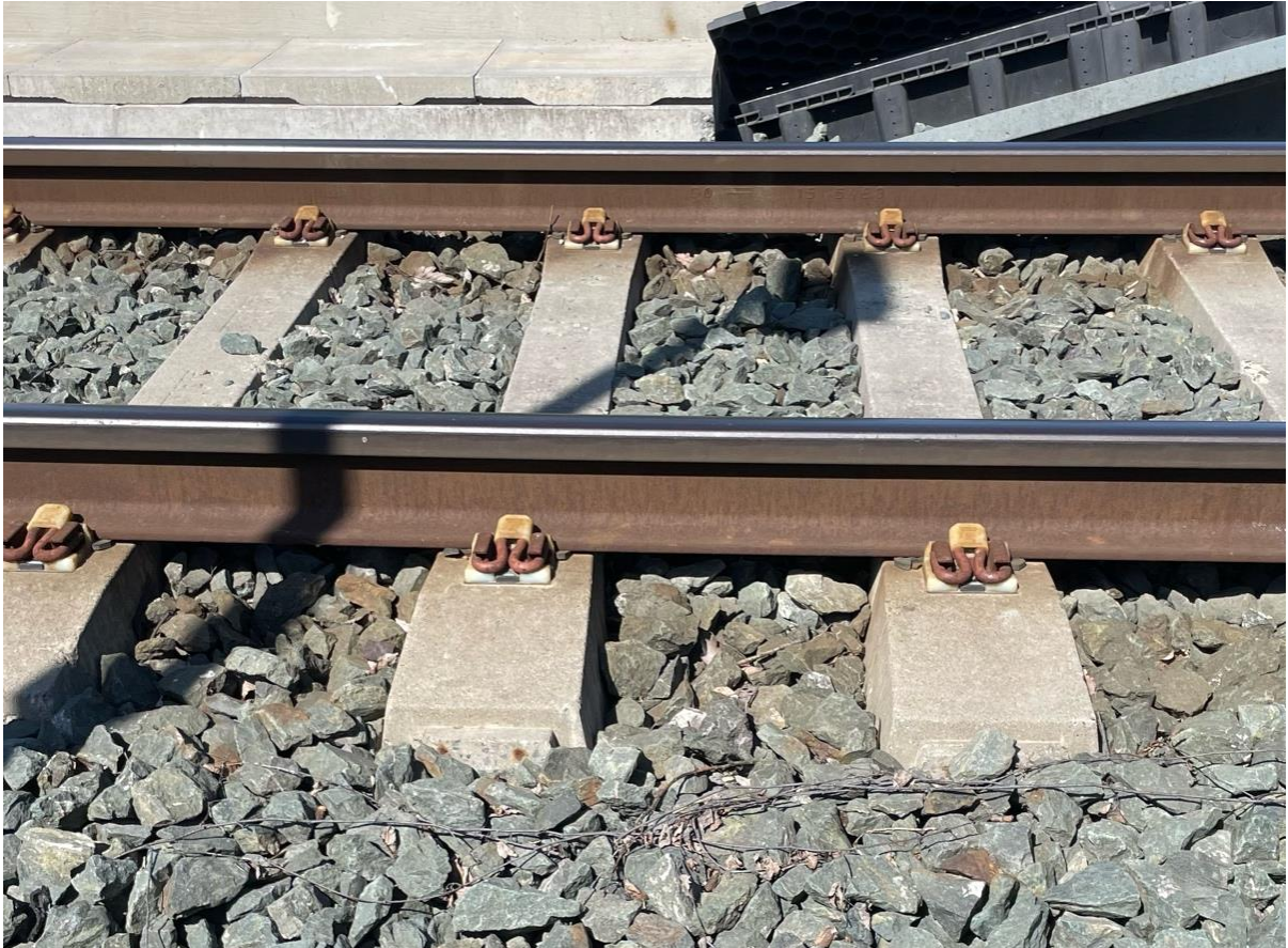
Figur 2-5: Monoblokk betongsviller. Bilde tatt ved Stavne bru.
