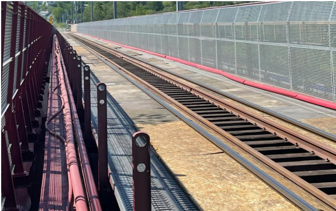
Figur 2-7: Tresviller brukt på bru i Norge. Bilde av Stavne bru.
