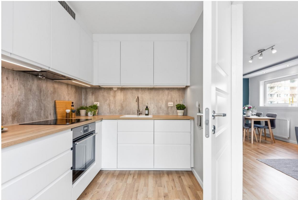
benkeplaten i heltre med underlimt kjøkkenvask og fliser mellom benk og overskap
