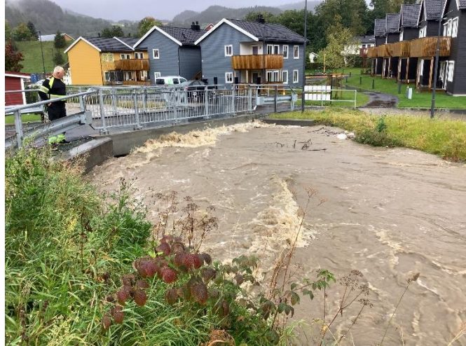
Figur 9. Gangbru over Litjskjeet, Ler sentrum. Av Melhus kommune (2022a).
