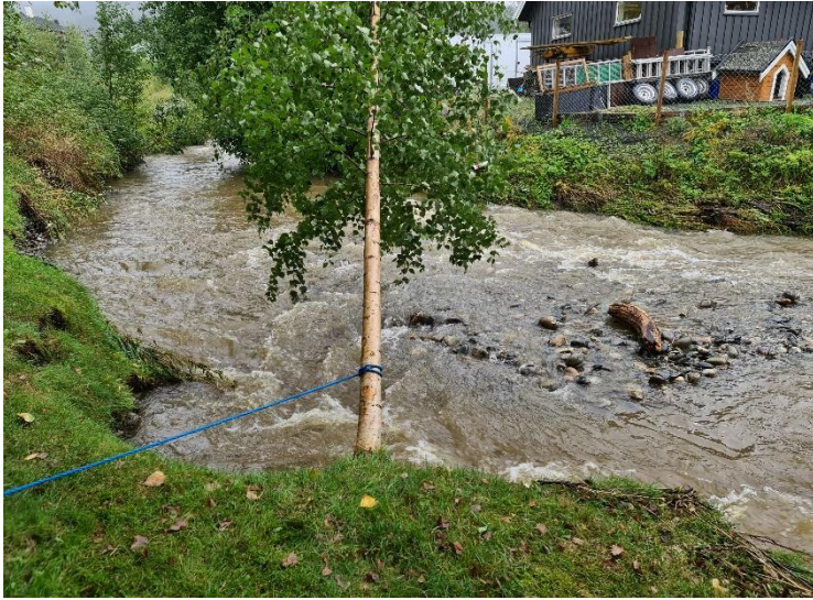
Figur 6. Trær og vegetasjon raser ut i elven. Sediment trolig avsatt etter flom. Av Melhus kommune (2022a).
