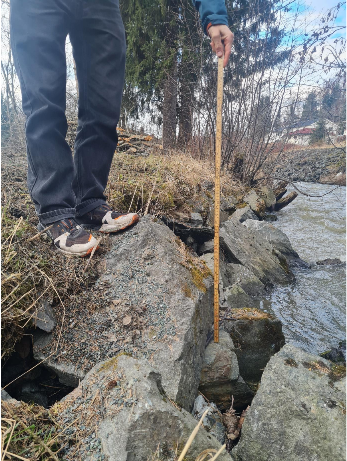
Figur V15. Store blokker i elvekanten. Trolig plassert der som et flomsikringstiltak.
