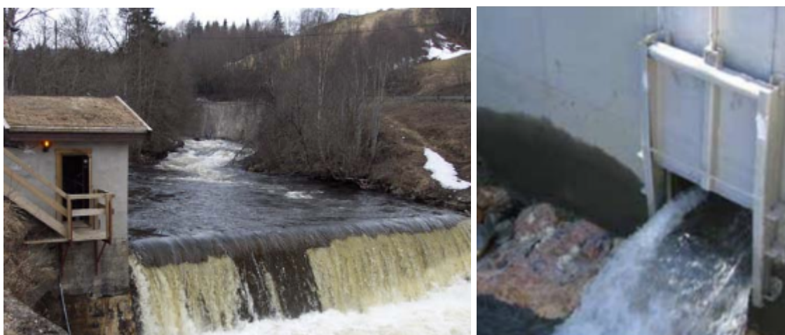
(a) Flomløp over betongdam [20]
