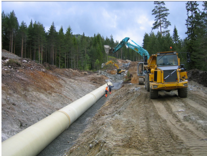
Figur 2.11: Etablering av nedgravd rørgate [51]
