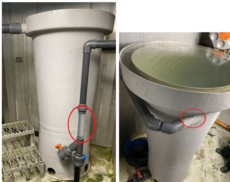
Figur 12: Bildene viser innløpsrøret til syklonen på to forskjellige steder. Den røde sirkelen på bildet til venstre er innløpsrøret like etter vannet har forlatt karet. Røret er sløpfet rundt syklonen, og går inn ved den røde sirkelen på bildet til høyre. Bilde fra: Gruppen
