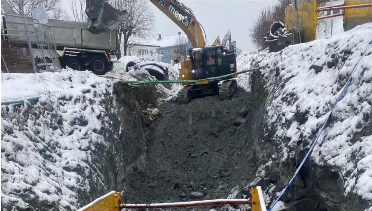
Figur 12 - Betong fra gamle hus i Bodø ble fyllmasse på VA-prosjekt (Hagen, 2024)
