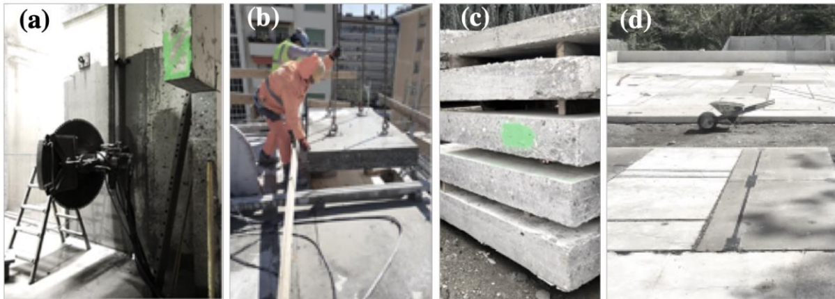
Figur 10 - Uttrekkingsprosessen av betongblokkene (C Küpfer1, 2022).
