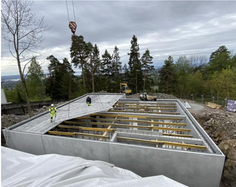
Figur 5 - Montering prefabrikkerte betong (Betongkonsept, 2023).
