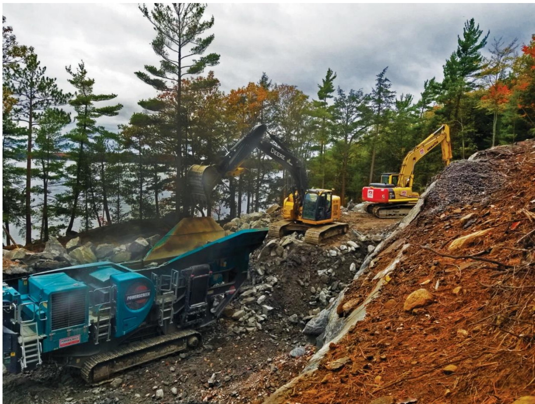
Figur 9 - Mobil betongknuser på en byggeplass Priestly Demolition (2024).
