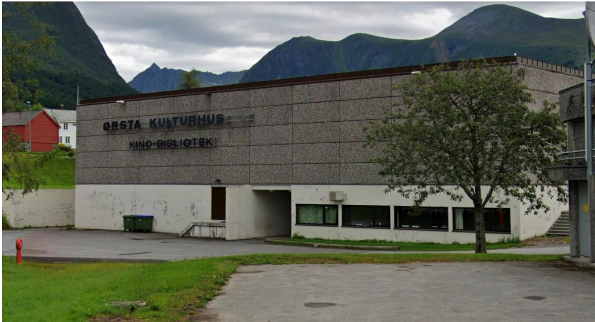
Figur 7 - Fasade av Ørsta kulturhus (google street view).
