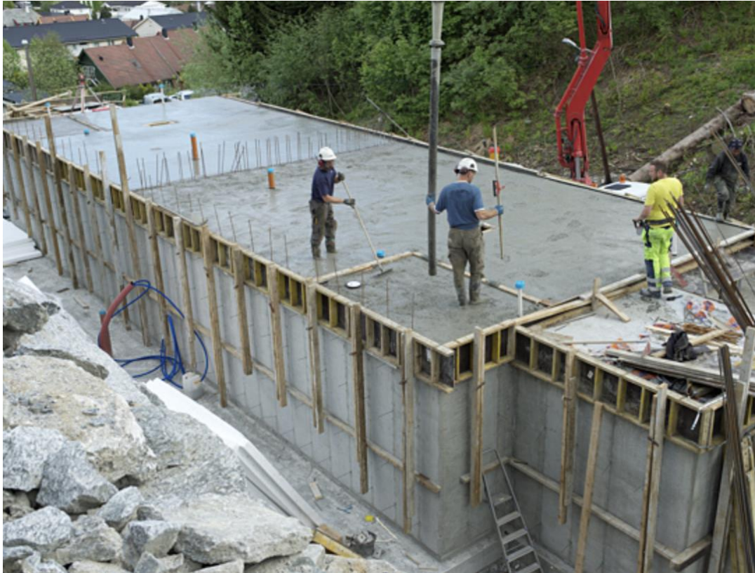
Figur 6 - Støping av gulv (blanderiet).
