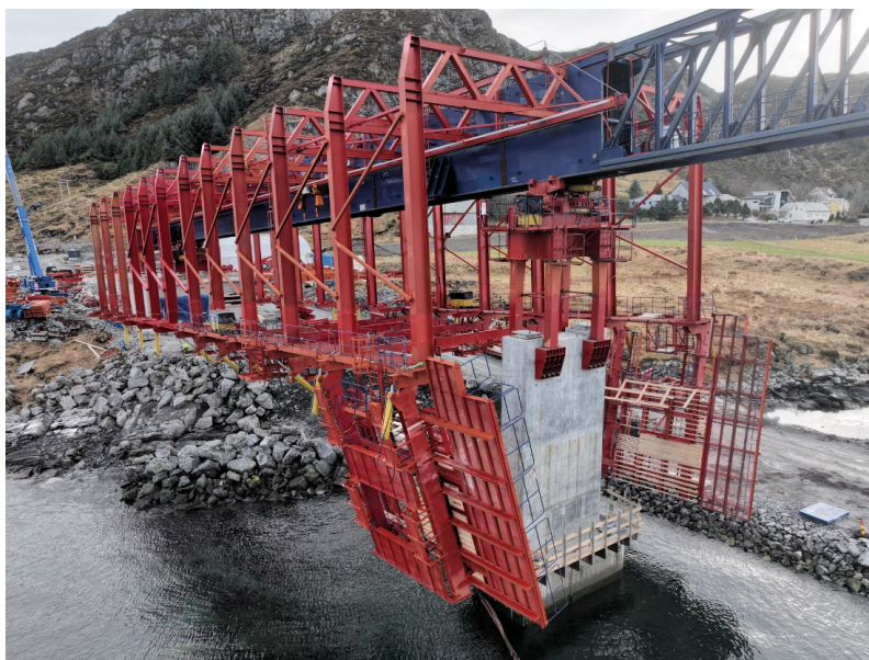
Figur 5: MSS - forskalingsvogn
