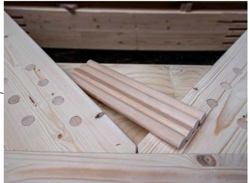
Innslissede plater endres fra stål til plater av bjørkefinér festet med tredybler
