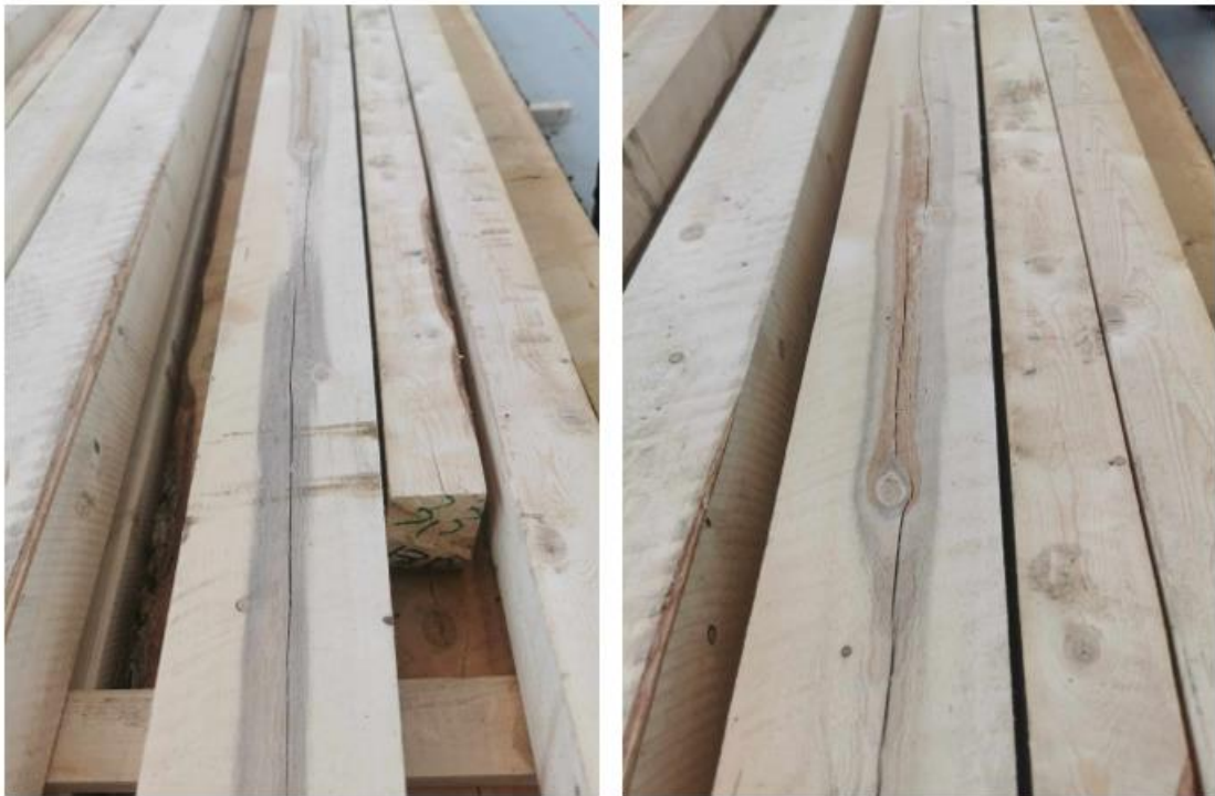
Bilde 15 12: Råte og brentved av 3A-B, foto: Silje Hoem Johansen
