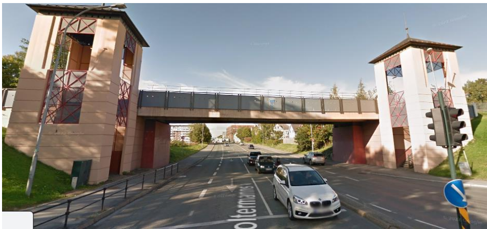
Figur 1. Bilde av den eksisterende brua. Bildet viser bruas nedbøyning. Utklipp hentet fra Google Maps [1].
