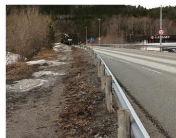
Figure 46: FV64 mot tussentunnelen
