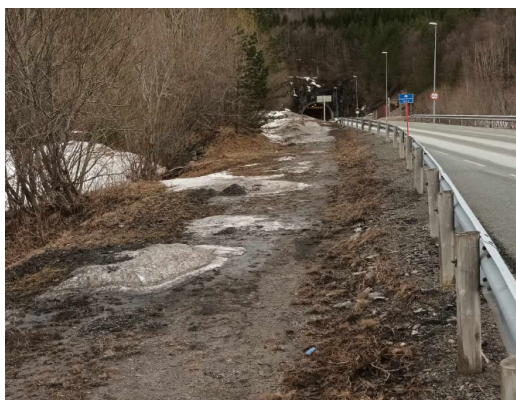
Figure 58: Tussentunnelen fra venstre side
