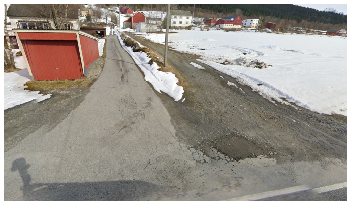
Figur 61: Sanering av avkjørsel profil 1250 (hentet fra Google maps)
