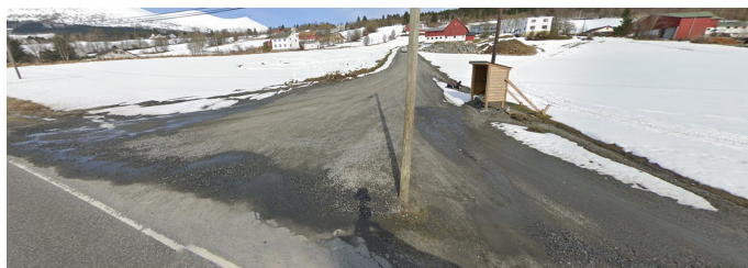
Figur 62: Sanering av avkjørsel profil 1370 (hentet fra Google maps)
