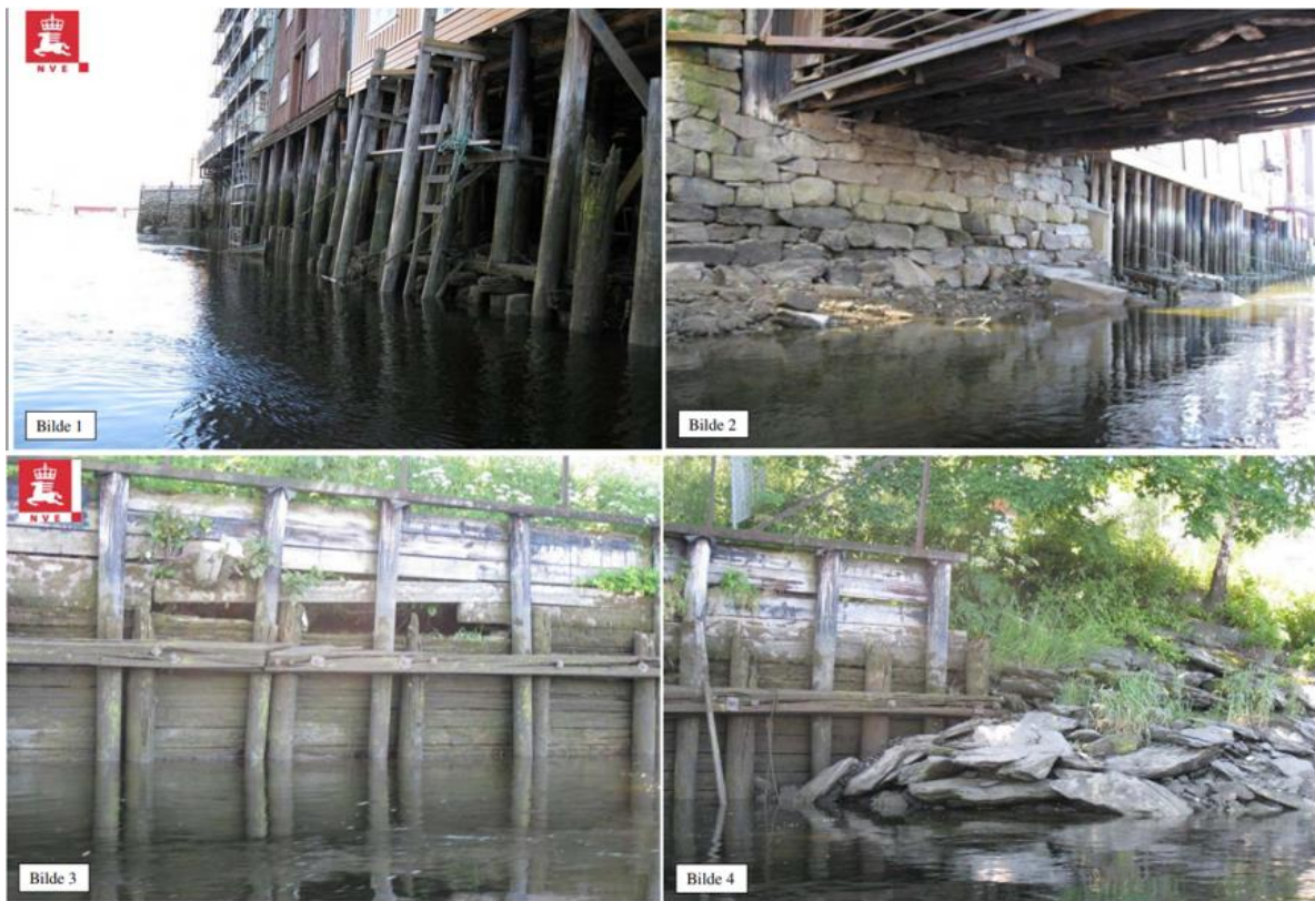
Figur 5: Erosjonssikring i Nidelva ved Baklandet 2009. Foto: Kristin Skei (2009)
