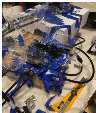
(j) Alle støpeformer fiksert og tildekt
