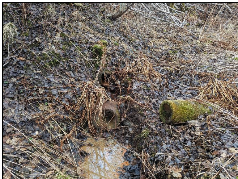
Figur 10 - Utløp fra kum 6770 til bekkeløp ved Måssåvegen, se vedlegg 7
