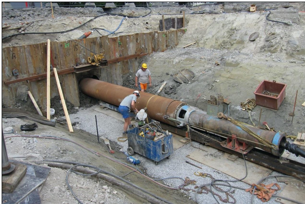
Figur 18 - Rørpressing under jernbane, bildet er hentet fra (Hallvard Ødegaard, 2019, s. 540)
