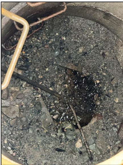
Figur 9 - Grusfylt overvannskum 6770 i Måssåvegen, se vedlegg 7
