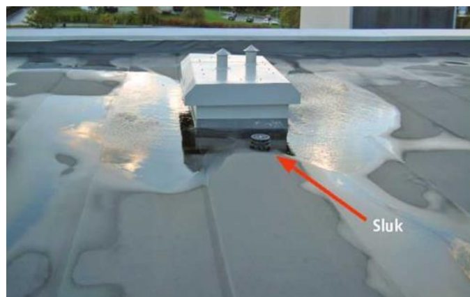
Figur 39: For lite fall mot sluk og hindringer. Hentet fra: SINTEF. [77]
