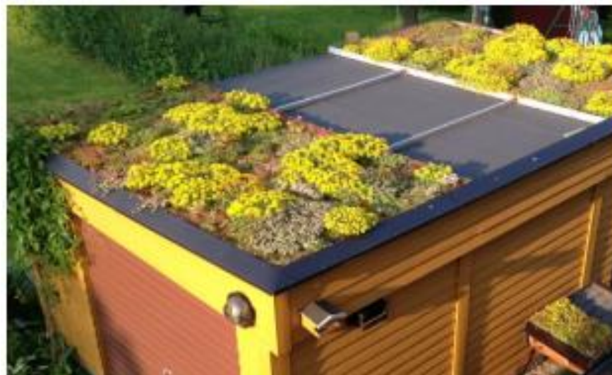
Figur 23: Grønt tak og referansetak på garasje i Oslo. Hentet fra: Norges vassdrags- og energidirektorat. [36]
