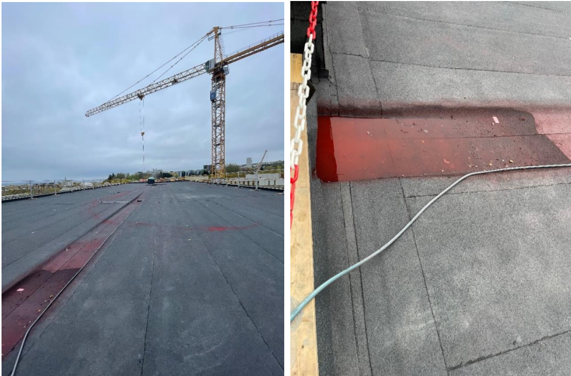
Figur 42: Kompakt takkonstruksjon der test er utført. Legg merke til rødfargen som er brukt. Hentet fra: Privat foto fra befaring på Teknostallen.
