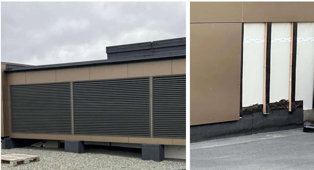
Figur 82: Takoppbygg på punktfundamenter (høyre) og oppbrett av takmembran mot fasade (venstre). Private bilder fra befaring på Teknostallen.
