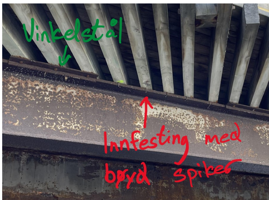
Figur 2.3: Festeordningen mellom ståldragerne og trebjelkene. (Foto: Haben Tewelde)
