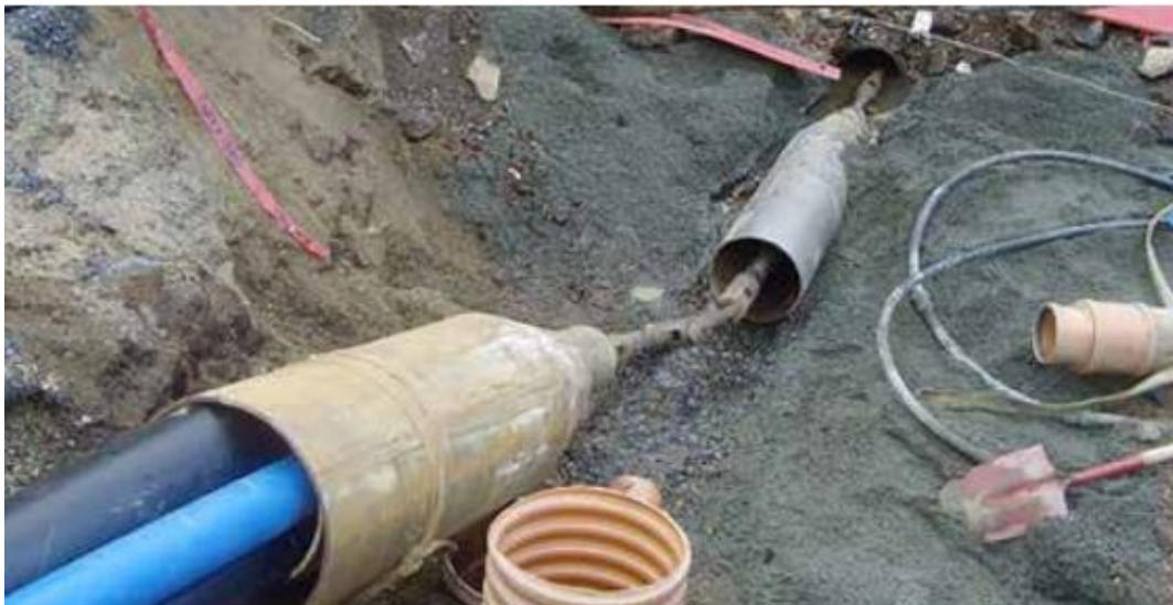
Figur 6 Utblokking med installasjon av tre nye rør i eksisterende rørtrasè (28).
