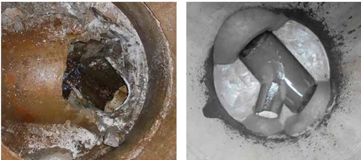
Figur 2 Til venstre så kan en se vanlig syn i norske kummer før fornying, og til høyre er det etter fornyingen (15).
