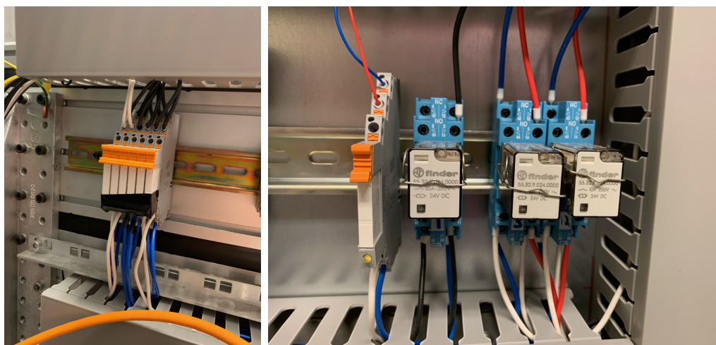
Figur 31: Reléene brukt i systemet. Venstre: Phoenix (med teip over indikatorlampen). Høyre: Finder
