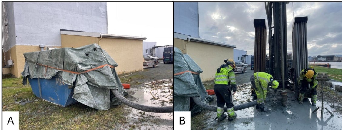
Figur 5.4: Bilde tatt under boringen av A) Kontainer med presenning dekkende over, her ble kaks og vann samlet opp under boringen. B) Manuell påkobling av røret som førte kaks og vann inn i kontaineren, dette ble gjort etter at løsmassene var boret igjennom.
