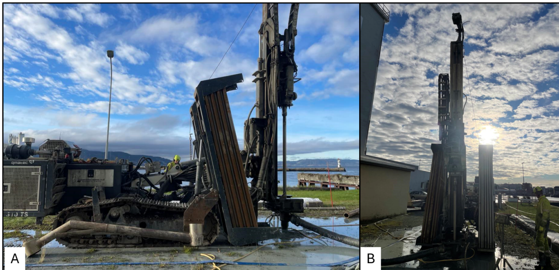
Figur 5.2: Bilde av boreutstryret benyttet under boringen av testbrønnen. Båsum Boring var entreprenøren som gjennomførte boringen og sto for utstyret. A) borutstyr fra siden B) borutstyr forfra.
