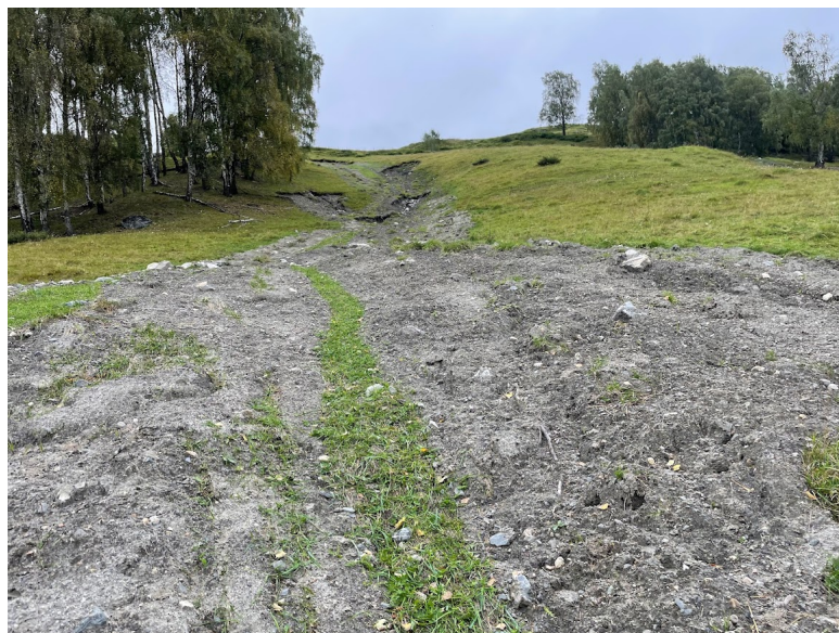
Figur 5.2.8: Skredmassene brer seg utover når skråningshelningen flater ut. Foto mangler skala.
