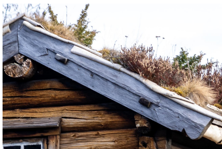
Figur 3.1: Nærbilde av detalj på vindski. En ser her at innhugget er lager en kant mot toppen av utskjæringen. Foto: Magnus Sigurd Lie
