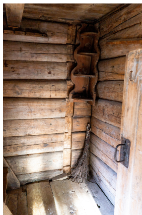
Figur 3.4: I vestveggen er det spor i tømmeret, som kan bety at veggen, som skiller forstuen og koven, har stått nærmere sørveggen enn idag. Foto: Magnus Sigurd Lie
