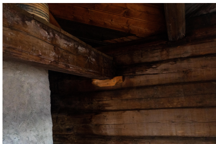
Figur 3.6: Nærbilde av støtte til bjelke i stuerommet. Foto: Magnus Sigurd Lie
