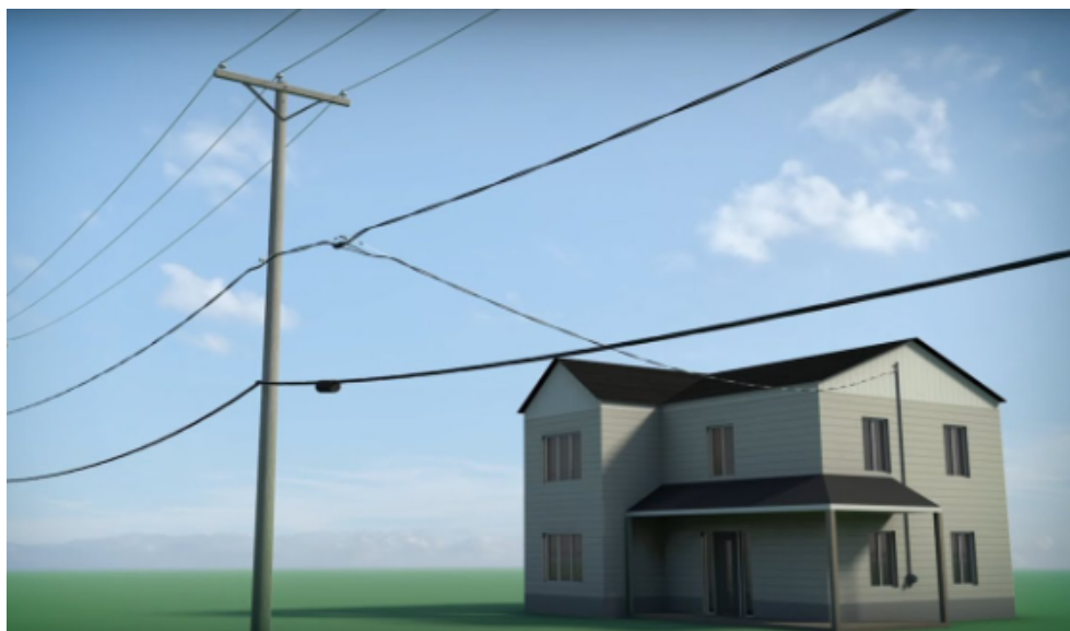
Figur 6.15 - Fellesføring høyspent og lavspenning [68]
