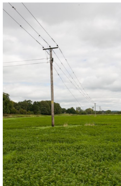
Figur 6.14 - 11 kV luftlinje [67]
