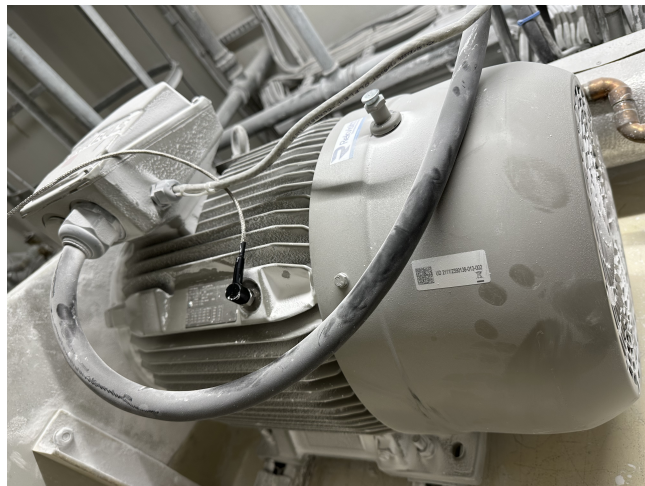
Figur 4.6: Vibrasjonssensor elmotor
