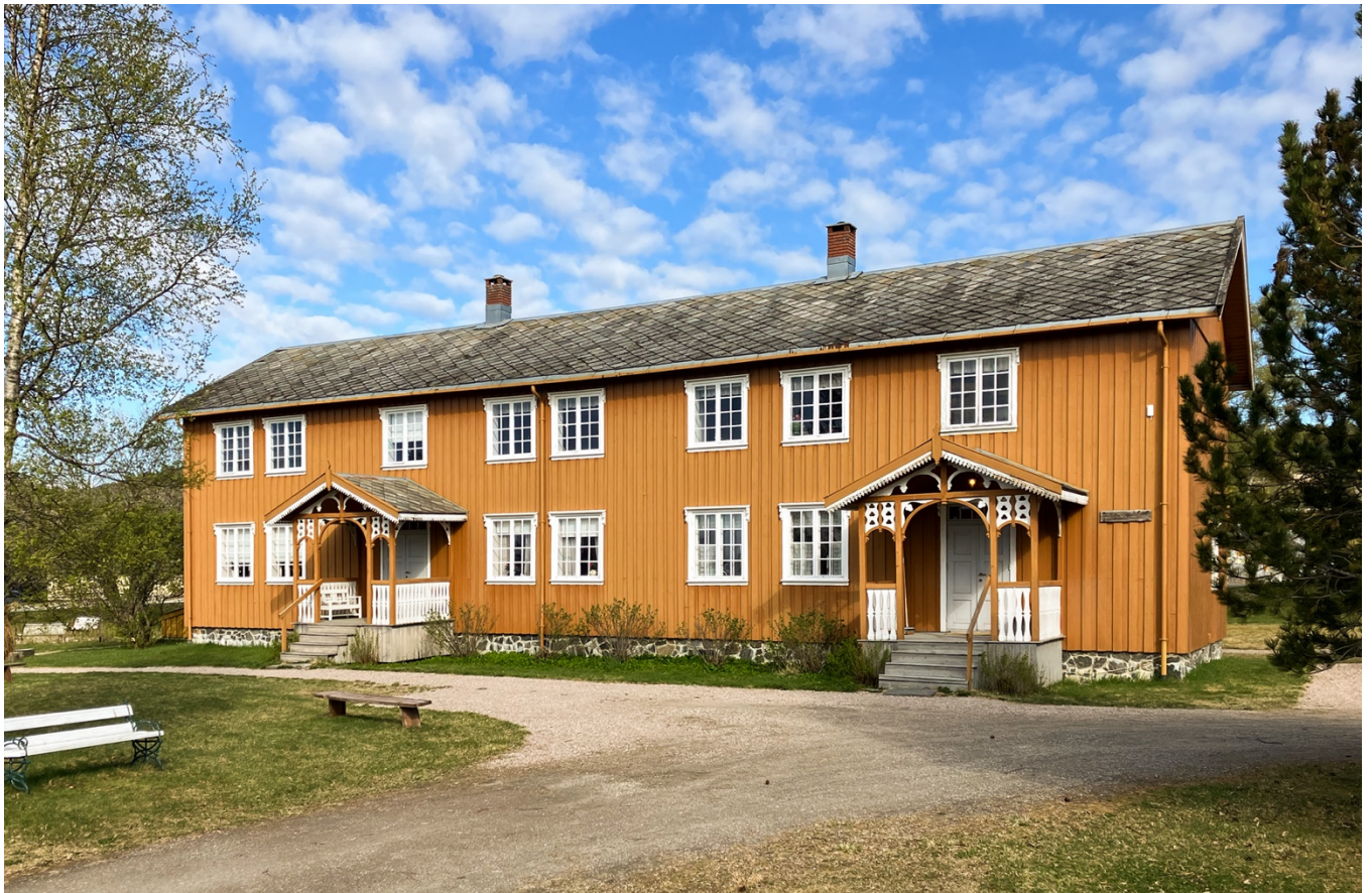
Halvardmolåna fra 1828. Det er i kjelleren til dette huset at hovedmagasinet til museet befinner seg. Foto: Eivind Skorstad.
