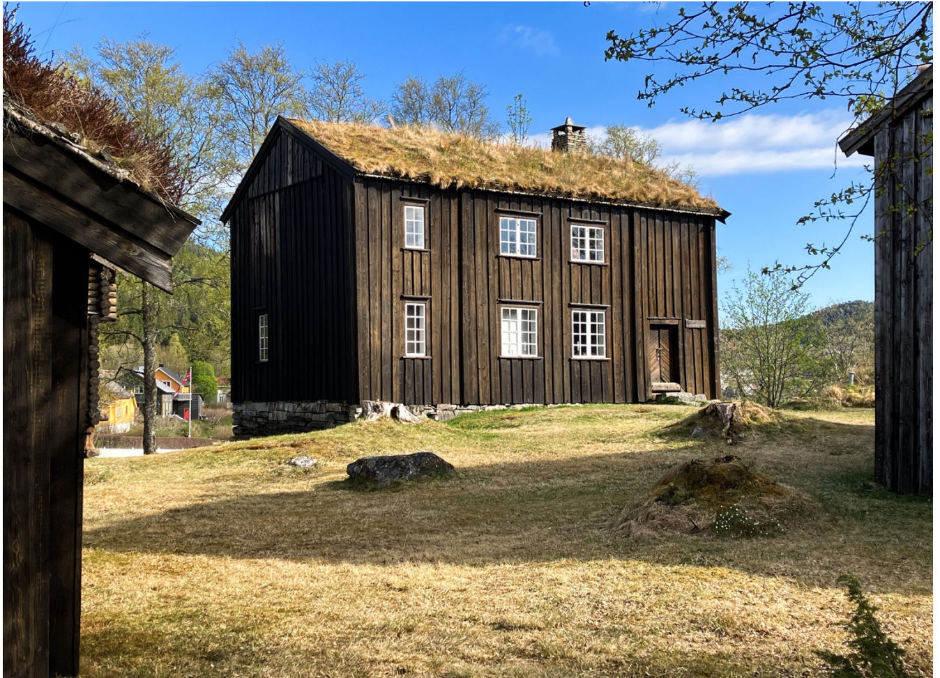
Svarliaunstua fra cirka 1790. Et av husene på Namdalsmuseet som det står utsilt/lagret mange gjenstander i. Foto: Eivind Skorstad.
