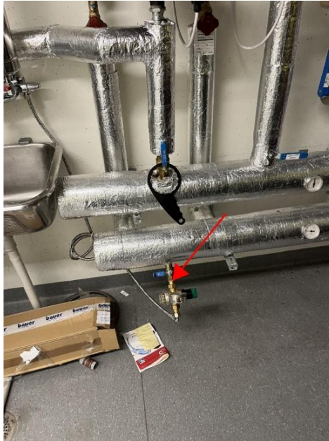
Figur 38 - Vannprøvepunkt Prinsens gate 83-85
