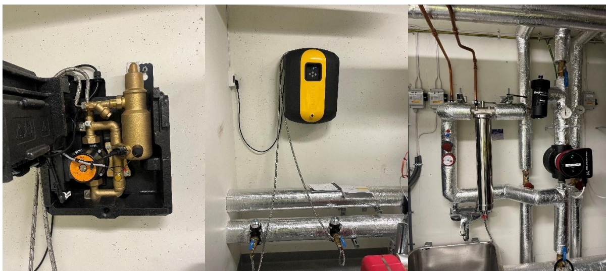
Figur 28 - Vannbehandlingsanlegg montert i Prinsens gate 83-85
