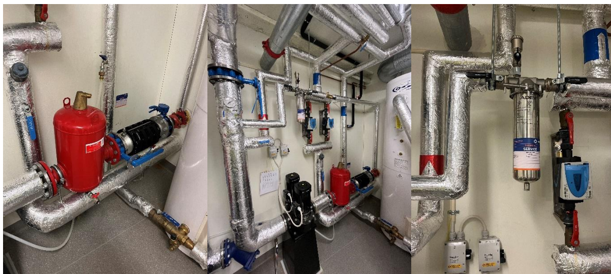
Figur 34 - Vannbehandlingsanlegg montert i Seilasveien borettslag
