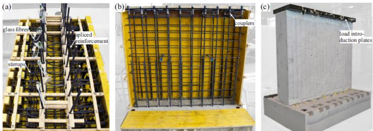
Figur 12 Testprøver vinkelstøttemur, før og etter støp [5]
