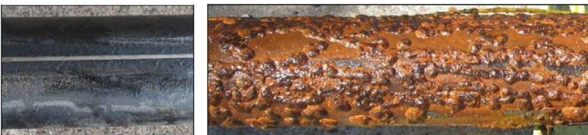
Figur 15. Pæler/rør som katodisk beskyttet (venstre) og ikke beskyttet (høyre) omtrent 1 år etter installasjon (Clark et al., 2010).
