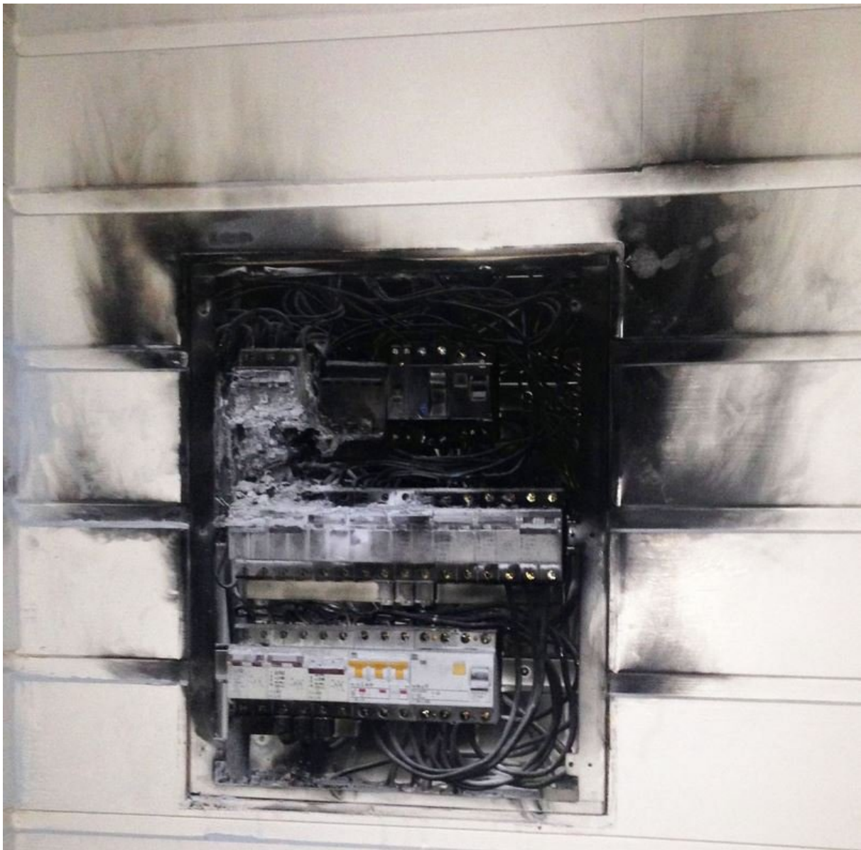
Figur 5: Hendelse i Re med gnistrende lyder fra sikringsskapet før brann[4]
