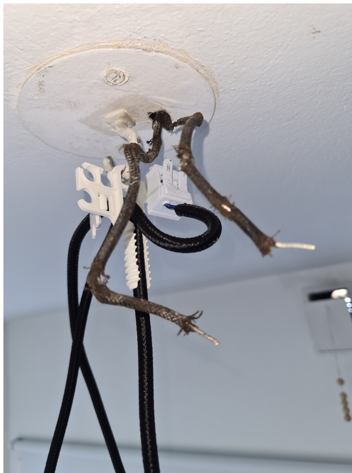
Figur 10: Gammel type ledninger [9]
