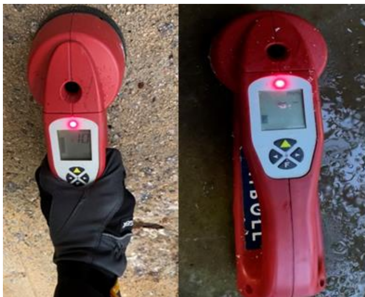
Figur 4.2 Overdekningsmåling under dekket (venstre) og overdekning over dekket (høyre)
