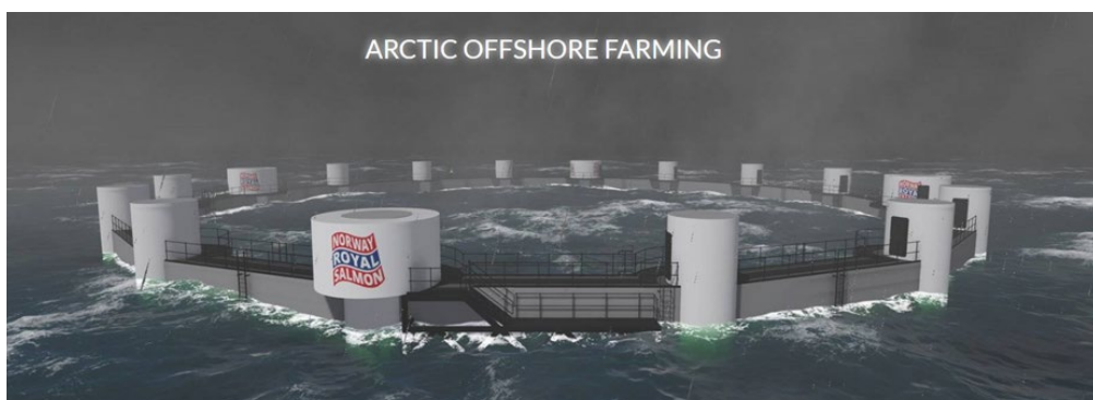
Figur 21.25. Arctic Offshore Farming er utviklet av Aker og Norway Royal Salmon. Et halvt nedsenkbart oppdrettsanlegg basert på betong.
