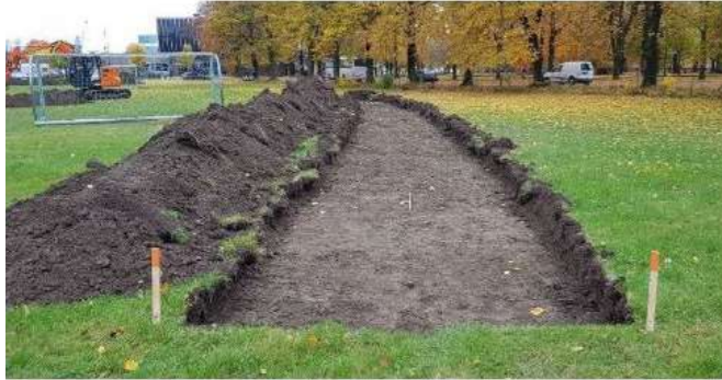
UNDERØKKT: Tomten til den nye svømmeanlegget i Tønsberg ble i løpet av høsten undersøkt for mulige kulturminner. Foto: Gorm Seljeseth, Vestfold Fylkeskommune
