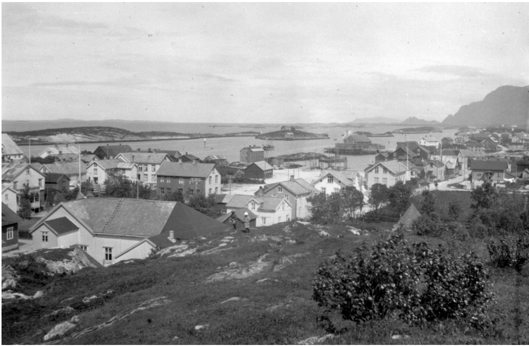
« Torvet blir til. Sett fra Høgåsen.
