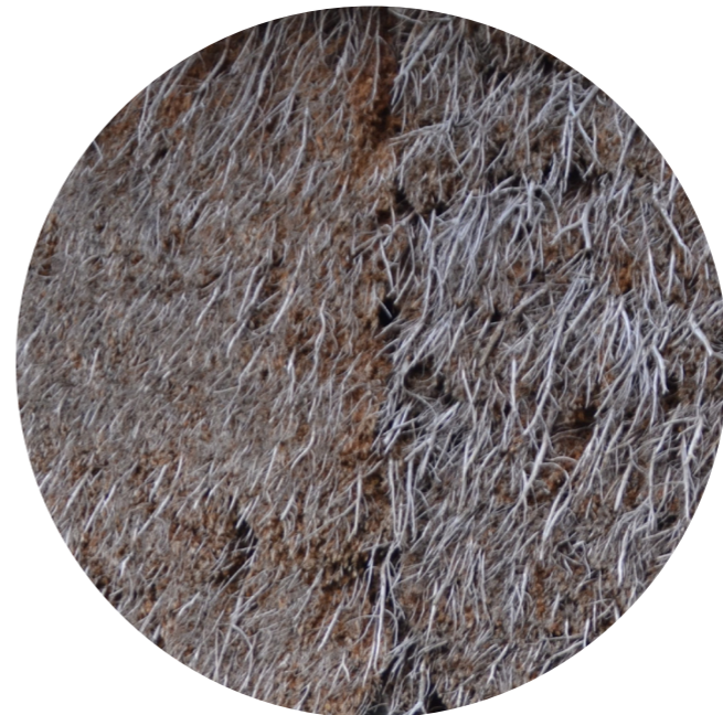
Brake som er mer enn ett år. Slik kan brakenkledningen være i opptil 100 år.
