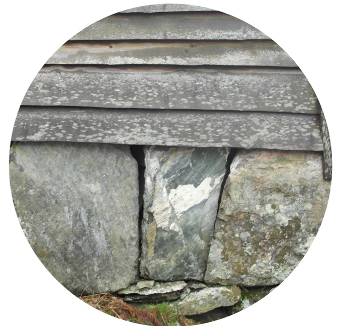
Steinheller på høykant og trekledning.
