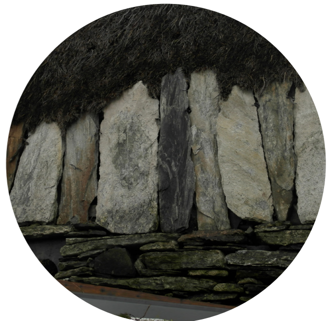
Stein på høykant over grunnmuren er vanlig i løer med brakekledning, for å hindre at slagregn kommer inn.
