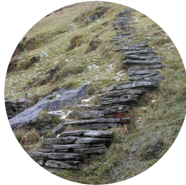
Stein blir brukt til å lage trapper i landskapet for å lettere komme seg frem i et kupert terreng.
