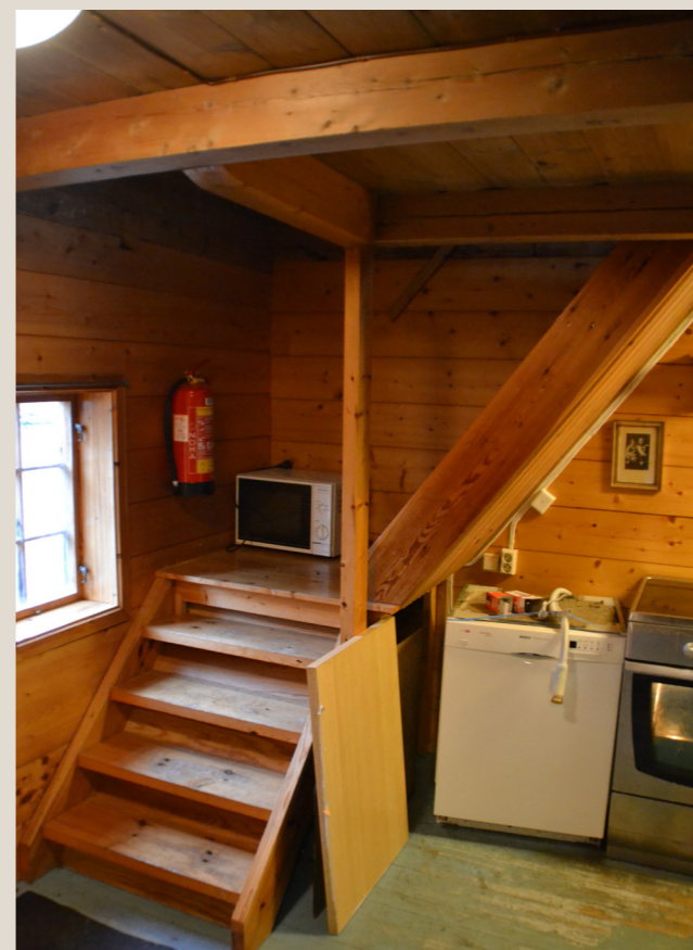
Smal trapp med knekk, som følger bjelkene i taket
