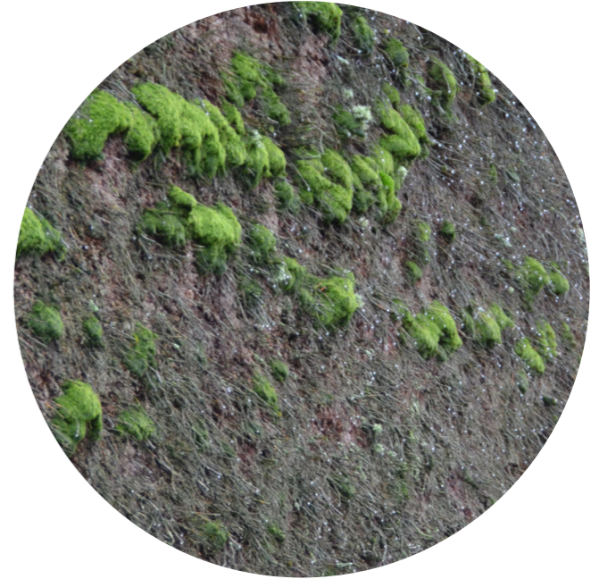
Braken er flettet for tett, derav begynner det å vokse mose utenpå, fordi luft ikke slipper gjennom.
