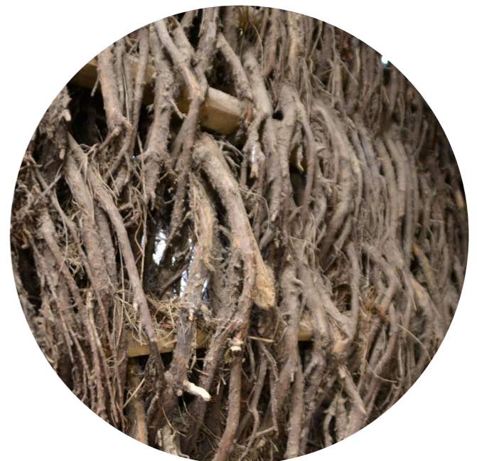
Fra innsiden kan man se kvistene som er flettet mellom spilene.
