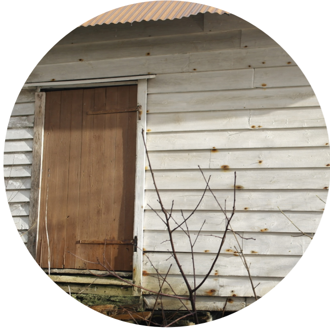
Liggende trekledning er den tradisjonelle måten å legge panel
