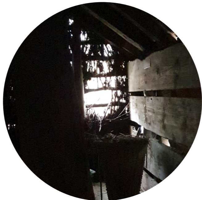
Eldre brake som har mistet en del av flettverket, og skapt et hull som slipper inn mye lys.
