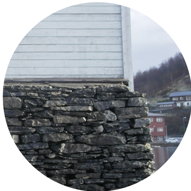
Vanlig overgang mellom stein og tre. Fra et av garverien på Valestrand.
