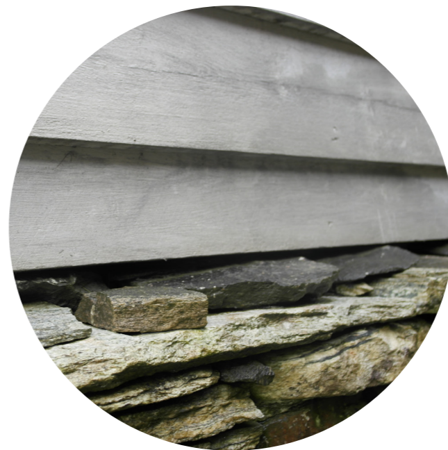
Detalj av steingrunnmur og trekledning.
