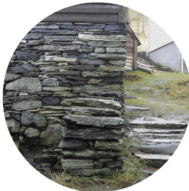
Stein på lag i grunnmur er vanlig
