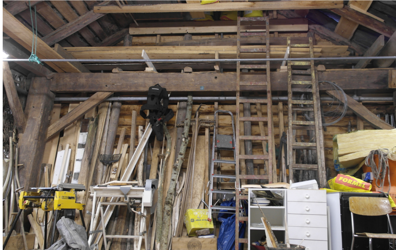
Bilde av tverveggen . Bak alt utstyret ser man grindkonstruksjonen.
