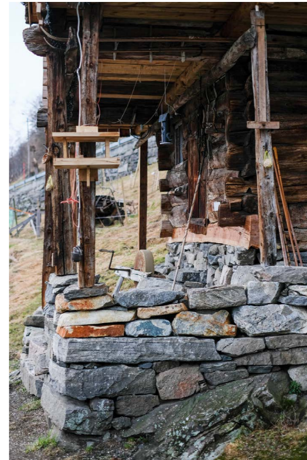
Steinmurfundamenter på Møllstunet i Geiranger. Egne foto.
