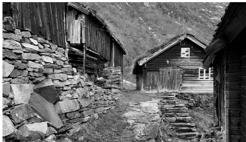
Tørrmurer tar opp for store høydeforskjeller på Møllstunet. Eget foto.
