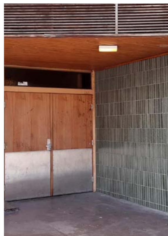
Dette overbygde inngangspartiet i sentrum hvor de kalde, grønne flisene og det varme treet er vakkert sammen
