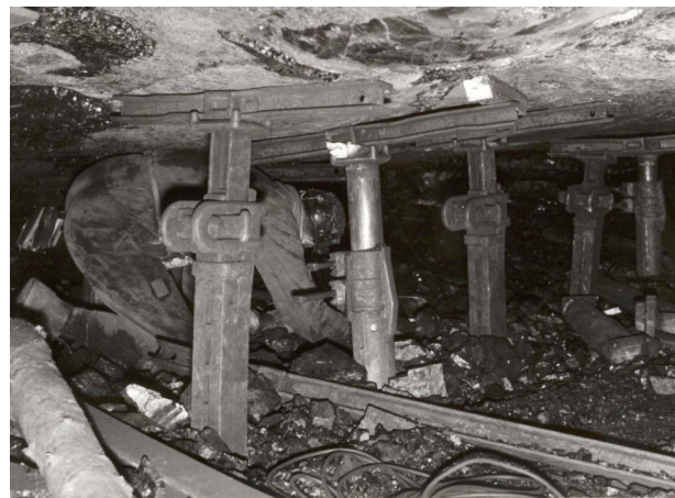
Stempelet ble brukt til å støtte opp hengt (taket i gruen) i strossa (området hvor kullet ble utvunnet). (Foto fra Svalbard museum).
