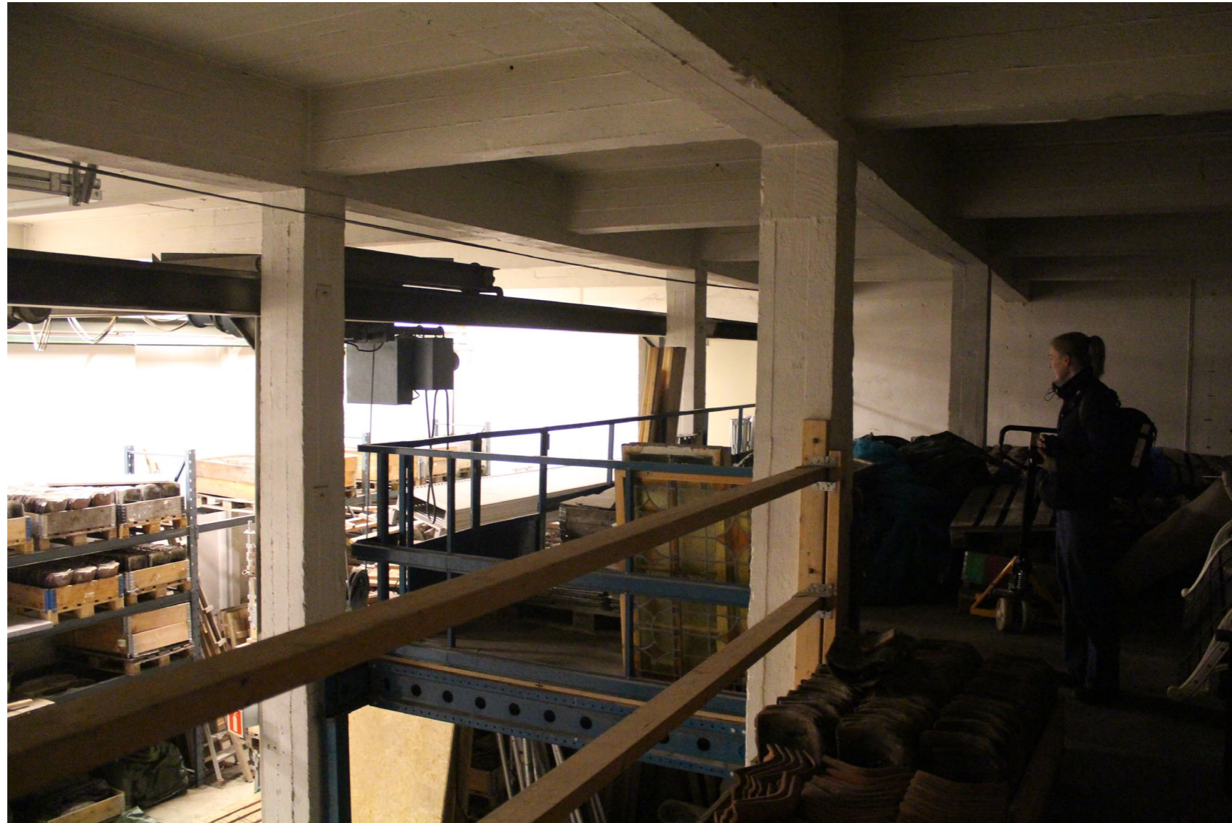
Lagerrom over to etasjer i Strandveien 100. kraftige betongbjelker i etasjeskillet og en moderne mesanin i stål.
