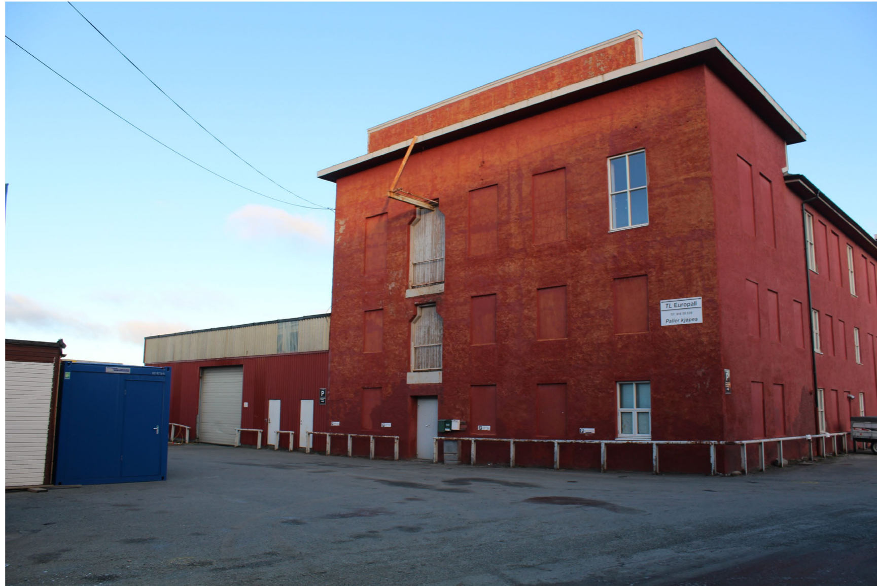
Fasade sør Skur 53b og Strandveien 100. Karakteristiske sjaktåpninger med rester av løfteanretning fra gesims
