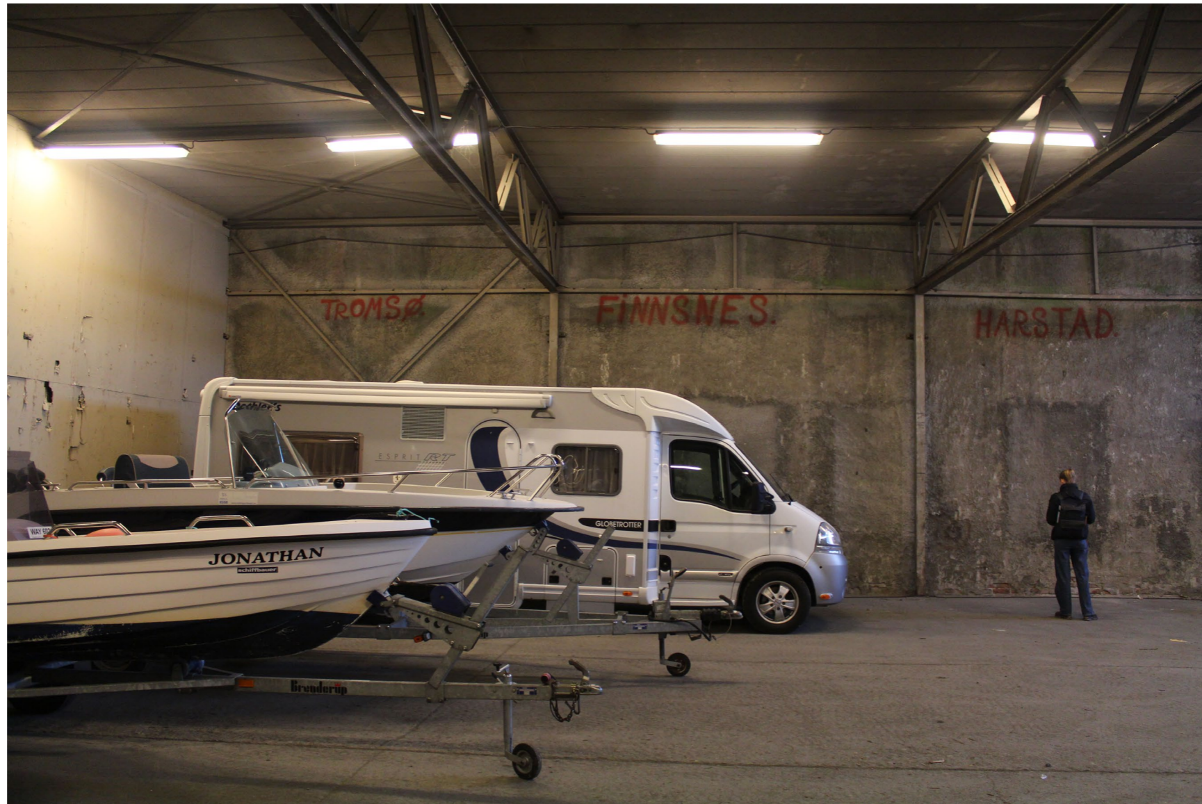
Innside Skur 53b. Skuret brukes som lager. I fasaden på Strandveikaia 100 syns restene etter de gjenmurte vinduene.
