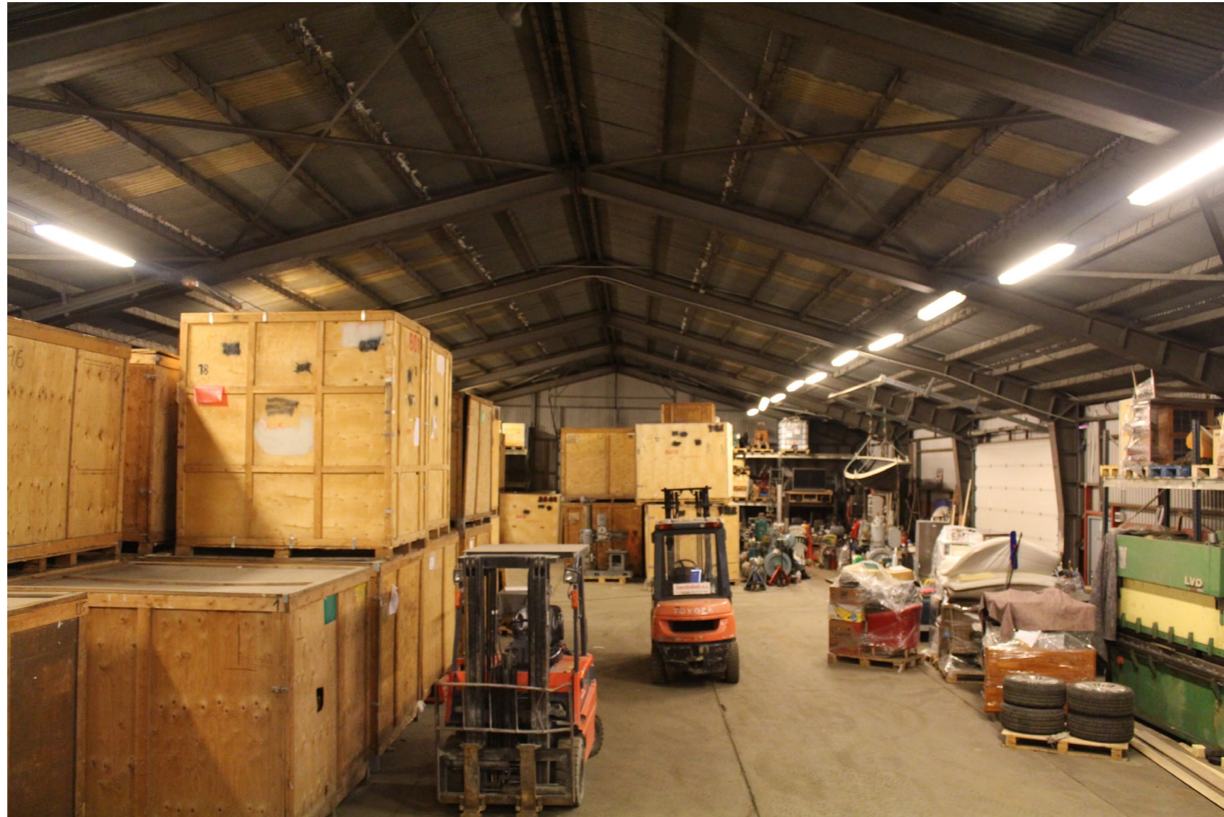
Innside Skur 53, betongheller på gulv og stålrammer som primærkonstruksjon
