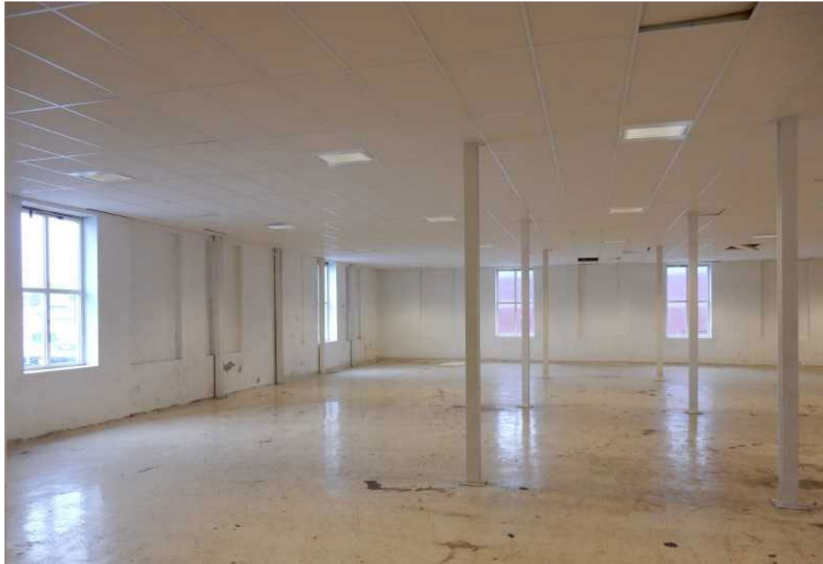
Et stort, åpent rom i 3 etg som strekker seg til enden av bygget. Rommet har fått en ny, senket himling
