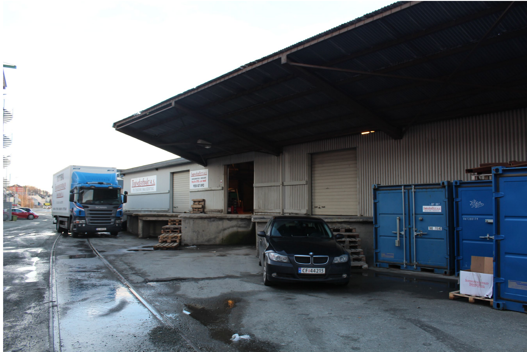
Lasteramper og overbygd tak Skur 53
