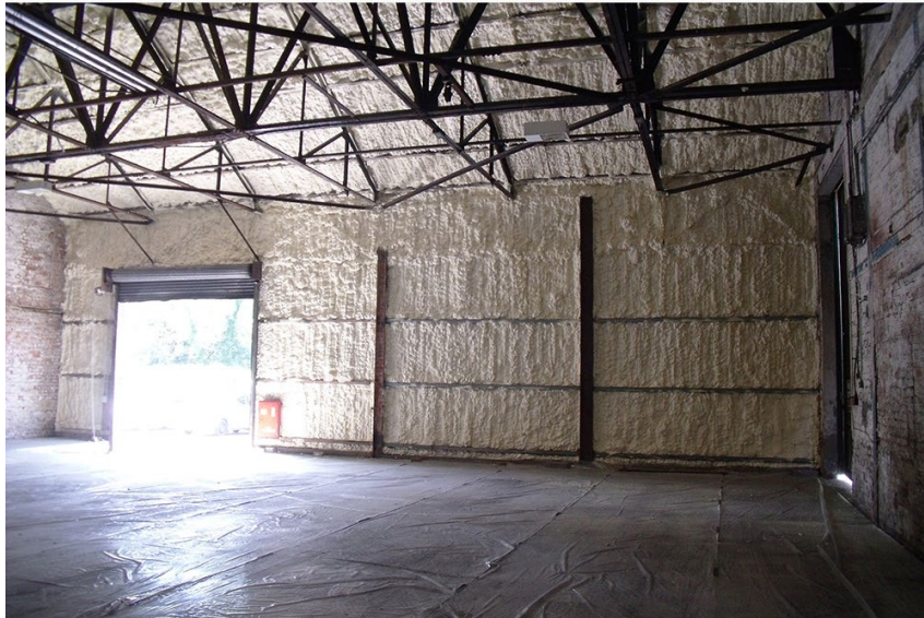
eksempel på etterisolering av uisolert struktur
