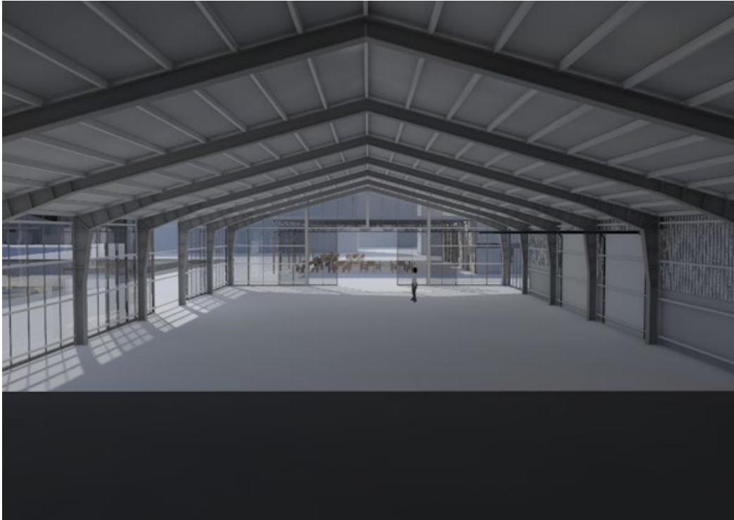
Åpen fasade mot kaia: gir ubalansert lysinnslipp
