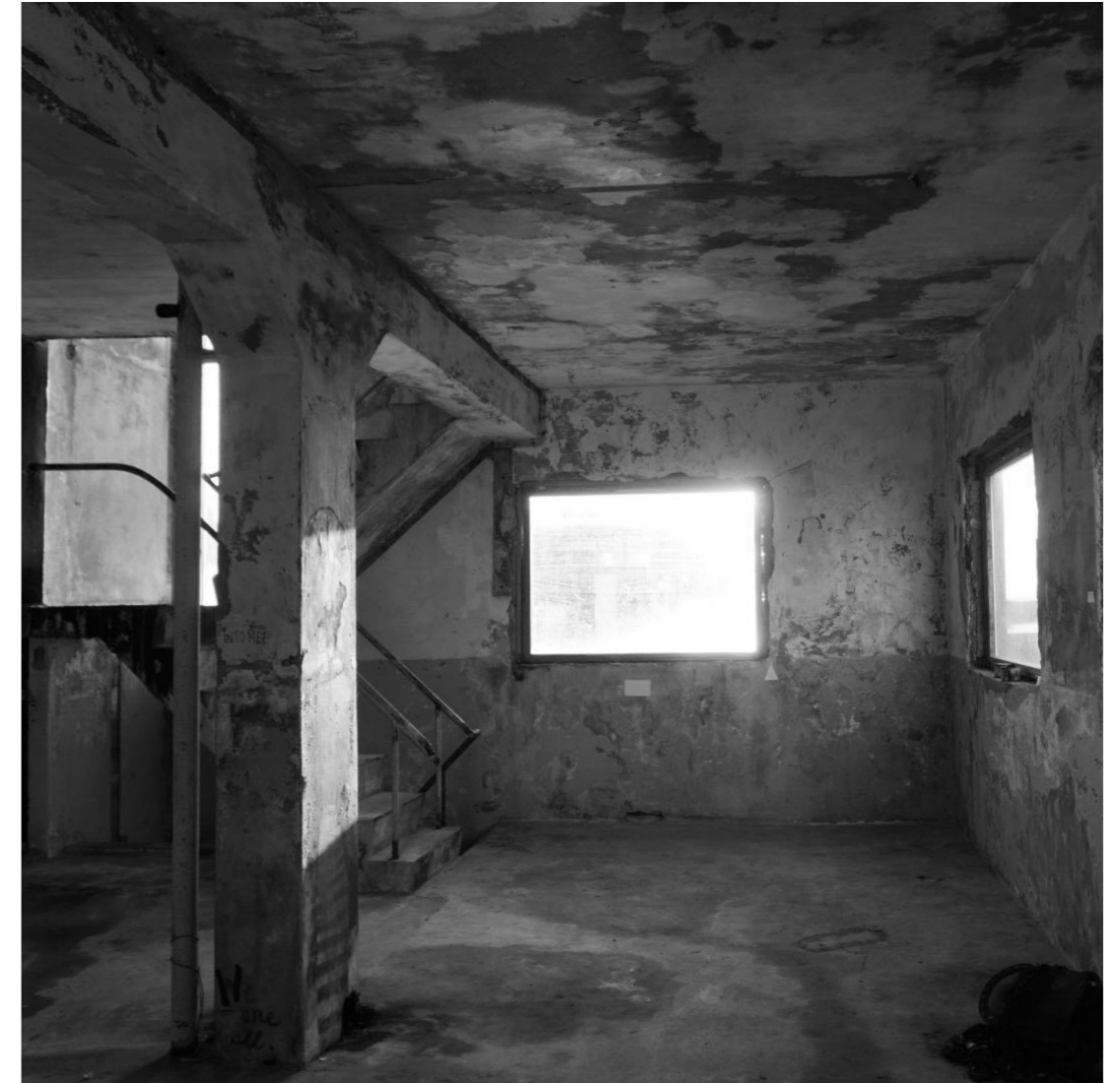
Bilde fra 2. etasje som viser eksisterende trapperom
