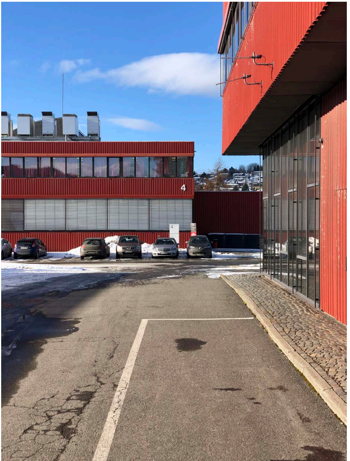
Administrasjonsbygningens base med verkstedbygningen i bakgrunn.
