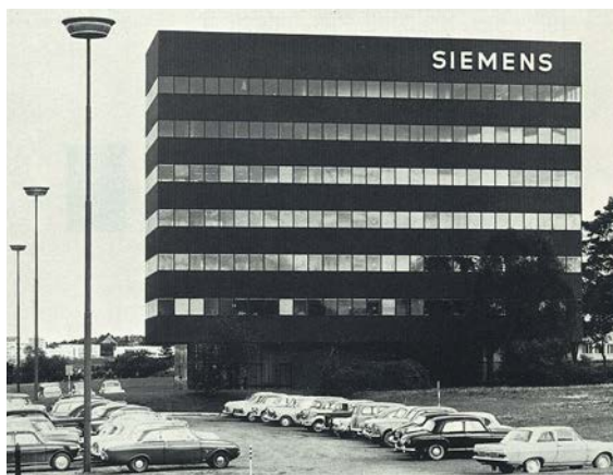
Siemens administrasjonsbygg, Sluppen Faksimile: Byggekunst nr 1, 1964
