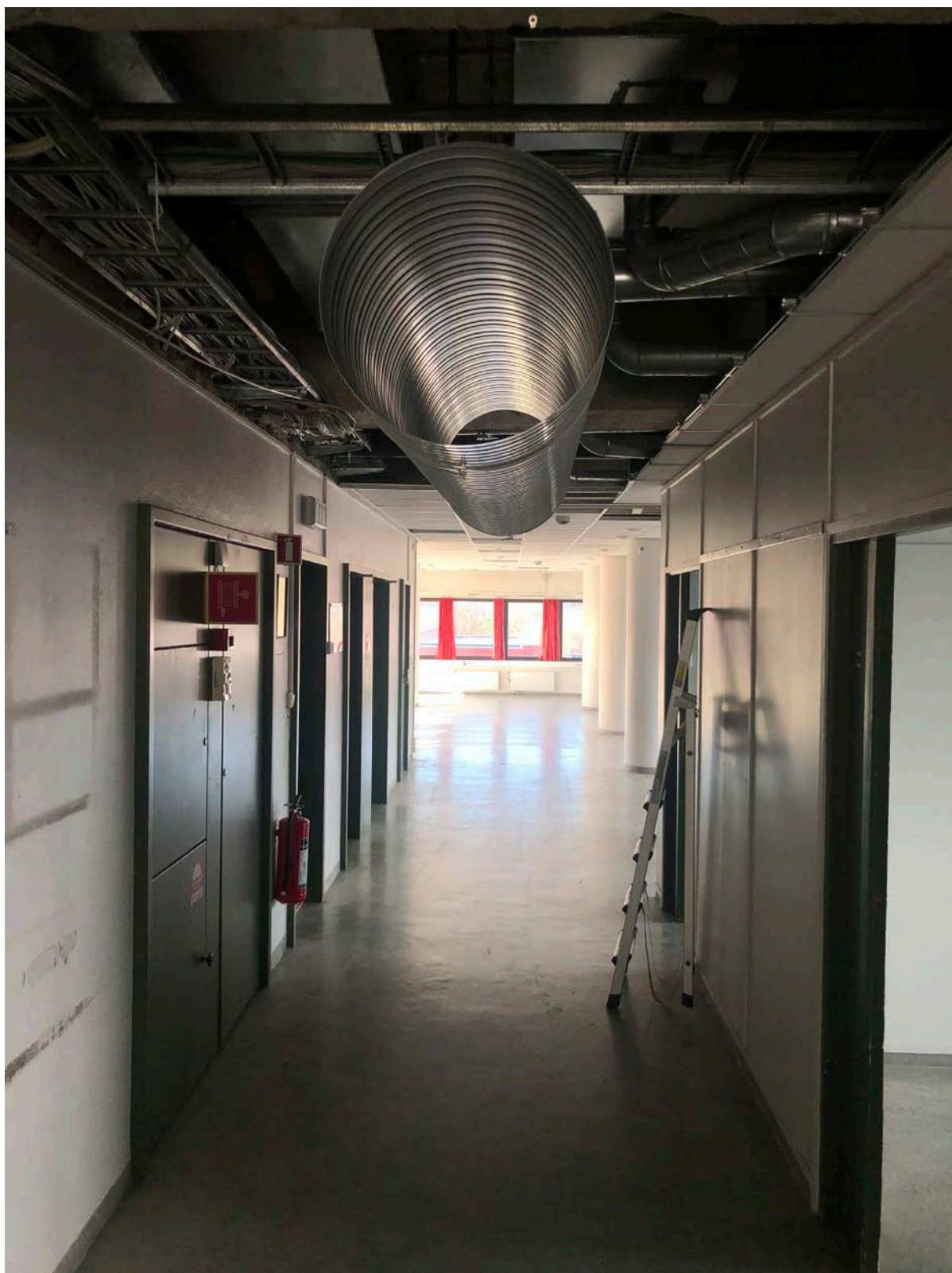
Cellekontor og servicekjerne i administrasjonsbygningen. Ventilasjonsrøret i taket skal illustrere plassbehovet for teknisk infrastruktur ved modernisering.
