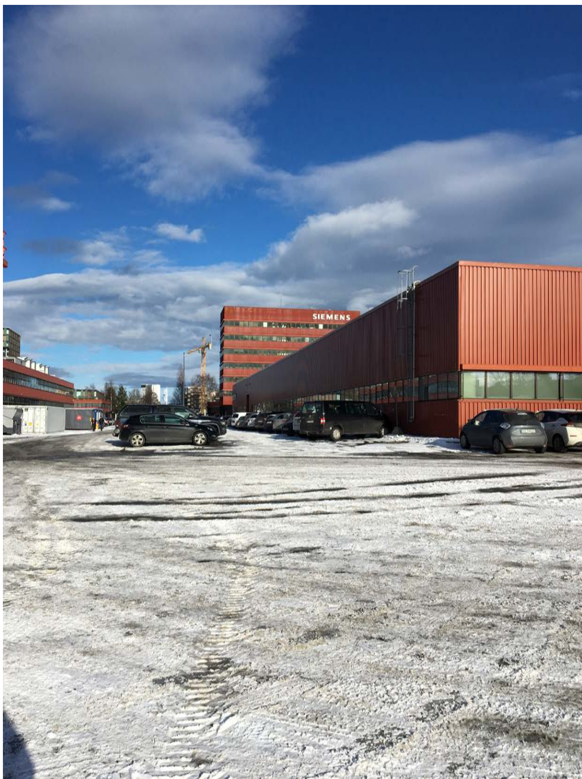
Elektrovarmefabrikken fra andre byggetrinn med administrasjonsbygningen i bakgrunn.
