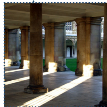
Passasje under Midtre bygg. Bilde fra Wren Library, Cambridge, England. Foto: Wikipedia
