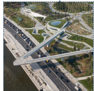
Offentlig gangbro. Bilde fra Zarydaye park, Moskva. Diller Scofidio Renfro. Foto: Iwan Baan.
