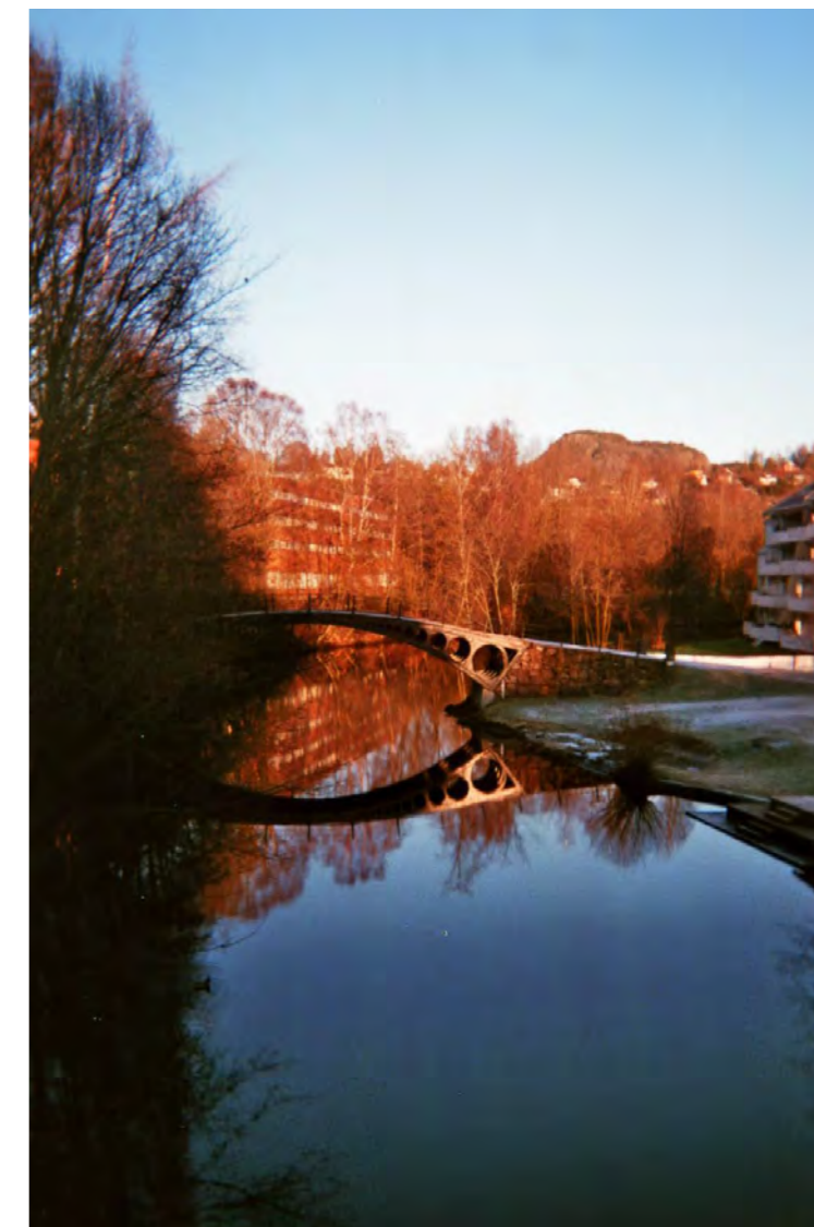
Fotografiet er tatt av Løkke bro med et engangskamera i januar 2020. Broen ble støpt på Bærums Verk i 1829.
