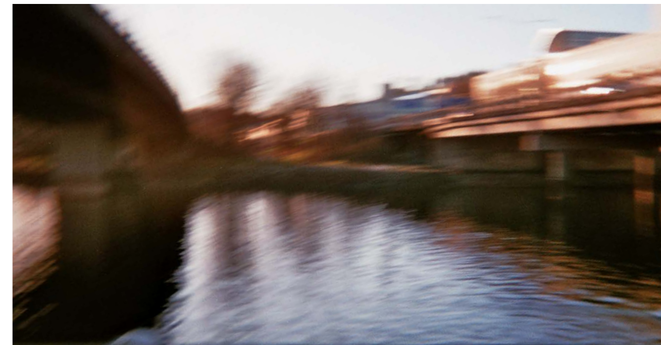
Fotografiet er tatt med et engangskamera i januar 2020. Til venstre går Sandviksveien, til høyre suser bilene forbi på E18. Transformatoren ligger gjemt bak brosylene til E18.
