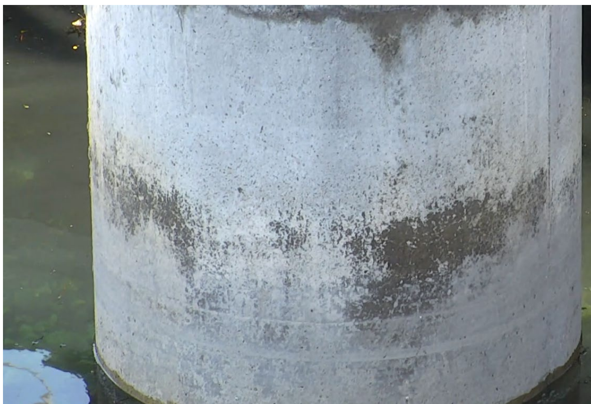
Bilde 14: Akse 6+7 fra nord, frost/ forvitring under kai/ i tidevannssonen.
