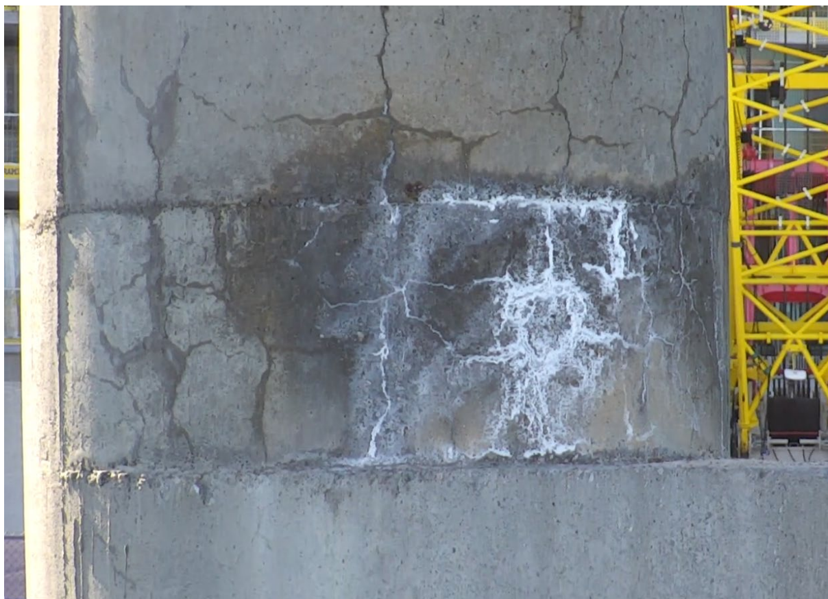
Bilde 9: Seksjon B, fra nord, kalkutslag i området hvor hul pilar ender.
