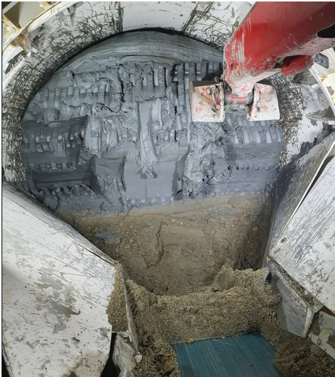
Figur 30: Mikrotunnelering med åpen front i Klæbuvegen-Nidelva kilde[Mottat fra Olimb AS]
