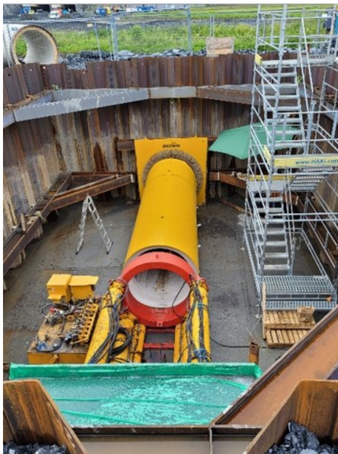
Figur 4: Mikrotunnelering
