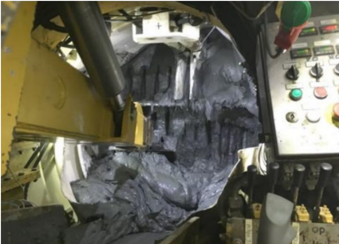
Figur 2: Utgraving av leire i tunneleringsfrotten kilde[13]
