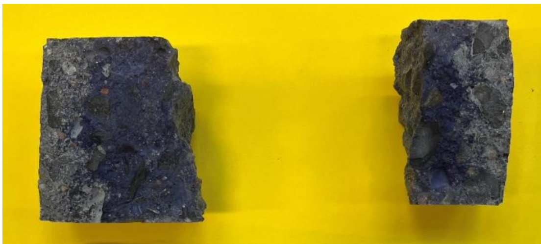
Figur 5.1.1: Eksempel på borkjerne påført indikatorvæske under etter testing av karbonatiseringsdybder. Skadet betong er uendret i fargen, mens frisk betong er blitt blå-lilla. Hentet fra vedlegg E.
