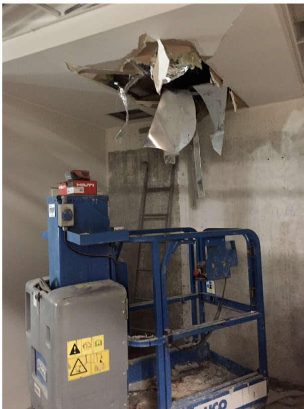
Figur 13: Hull sett fra 1. etasje.
