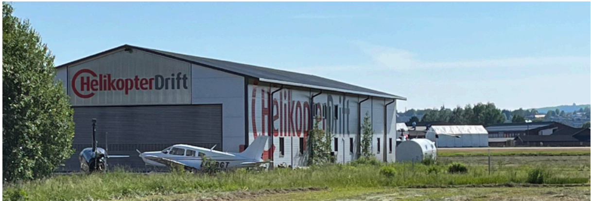
Bilde 31, En av hangarene langs flystripen på Kjeller flyplass. Foto: Magnus Helvig Klefos Johannessen
